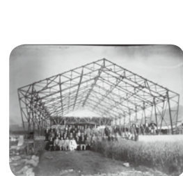
▲昭和23年旧高甫小学校体育館棟上式記念写真
